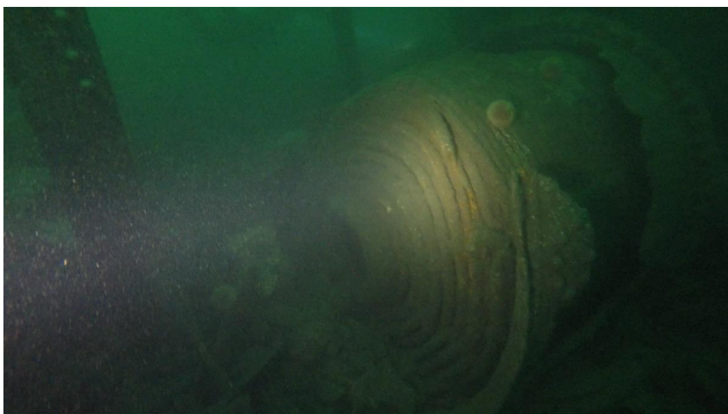
Een klein drukvat in de buurt van de motor. Waarschijnlijk door het temperatuur verschil van het water is deze opengeklapt. De kleine leidingen zijn nog goed zichtbaar.
